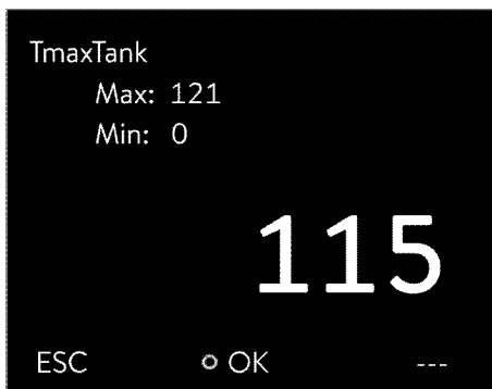
Fig. 35: Introducción del nuevo valor Tmax-Tank
